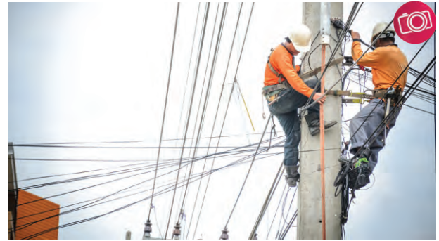
Fig. 28. Electricieni de rețele electrice
