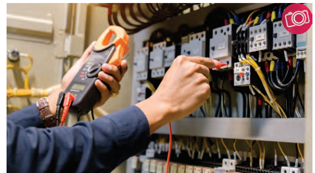
Fig. 29. Instalator echipamente electrice
