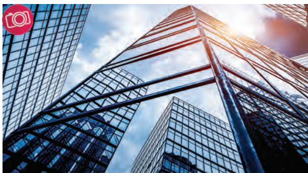
Fig. 23. Clădire modernă cu pereții din sticlă
